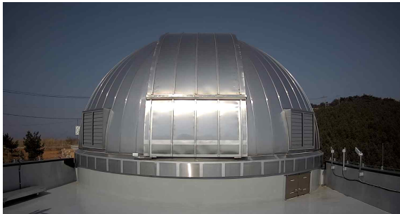
그림 4. 한국 천문연구원 거창 감악산 사이트 SLR 8.5m 자동 제어 돔.
